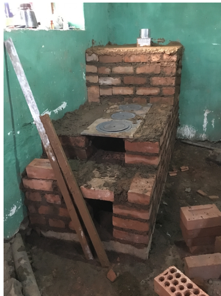
Figure 12 : Construction d'une cocina mejorada à Ullucurán
