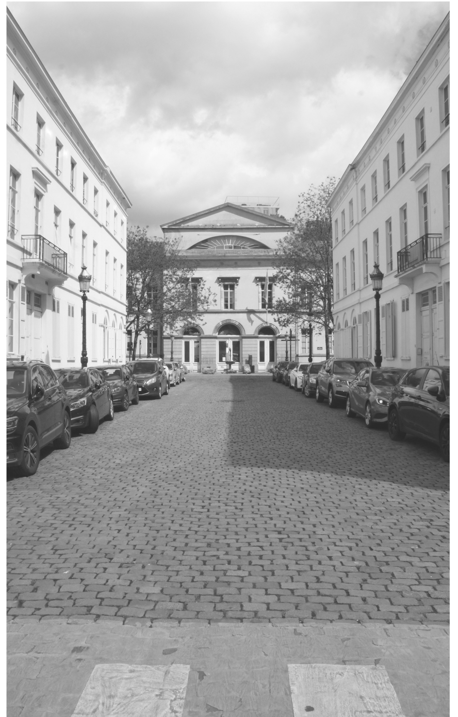
L'hospice Pacheco, édifice néo-classique à l'architecture remarquable et véritable patrimoine de la ville est toujours la propriété du CPAS de la ville de Bruxelles. Depuis plusieurs années, il est cependant vide et fait aujourd'hui l'objet d'un appel à projets.
