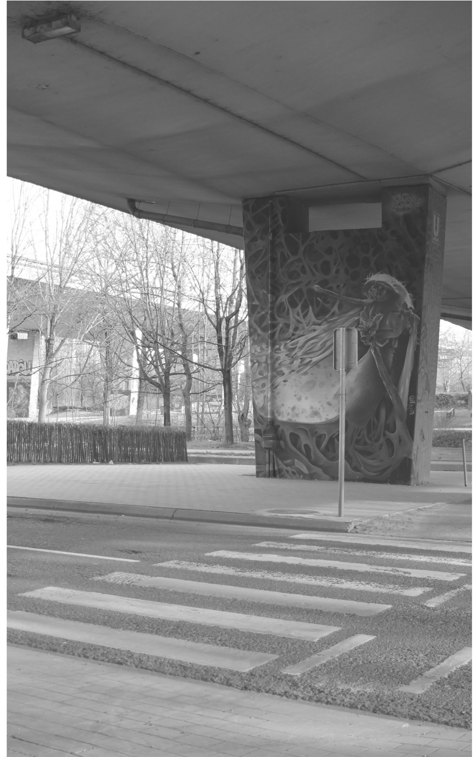
Le viduc de l'autoroute agit comme une fracture au sein de ces espaces. Bien que les zones soient vertes et plantées, les liaisons sont compliquées.
