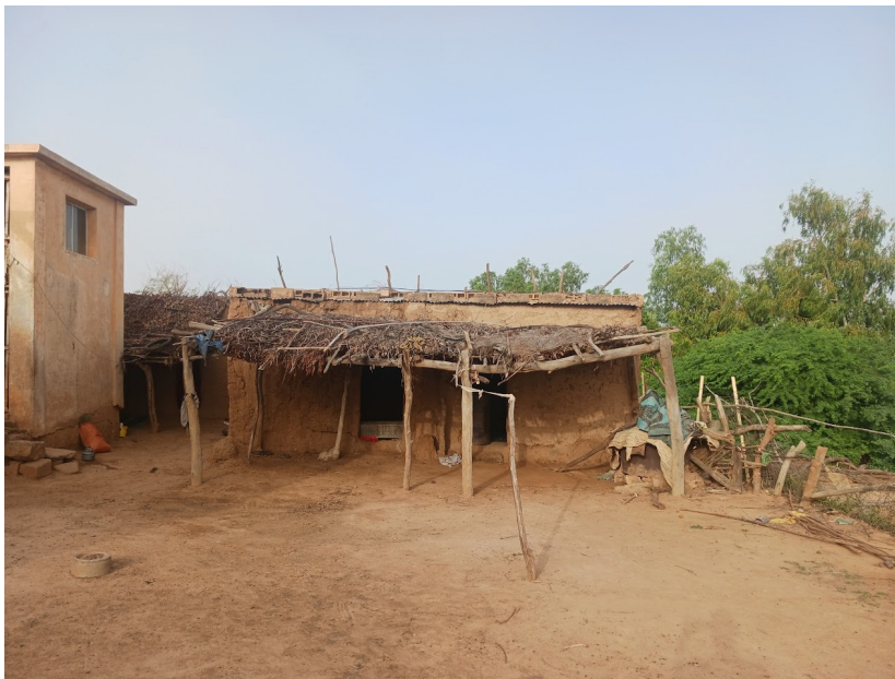
Fig. 73 Maison du gardien aux abords du barrage
