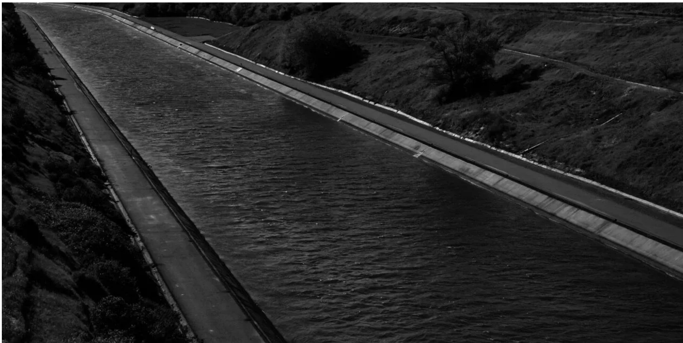
Fig 6. Canal principal d'irrigation
