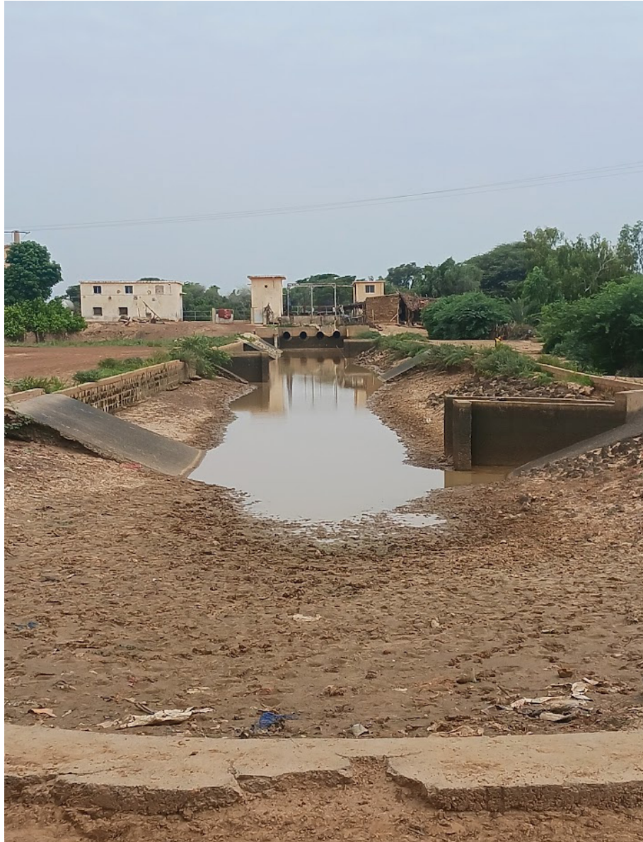
Fig. 66 Barrage de Guédé Chantier
