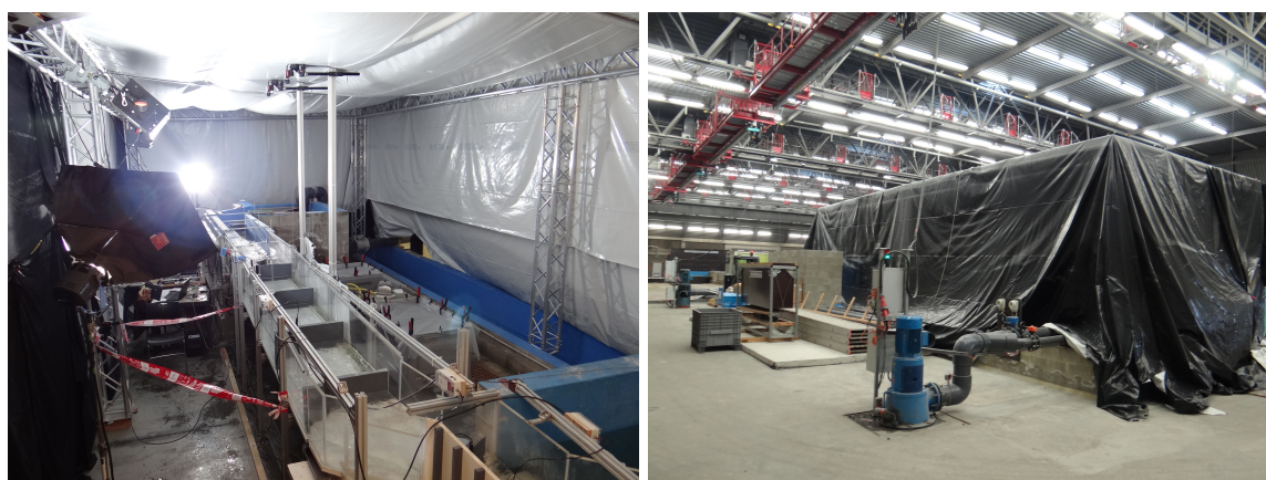
FIGURE 4.10 – Vues extérieure et intérieure du modèle après la couverture par la bâche et l'installation des projecteurs
