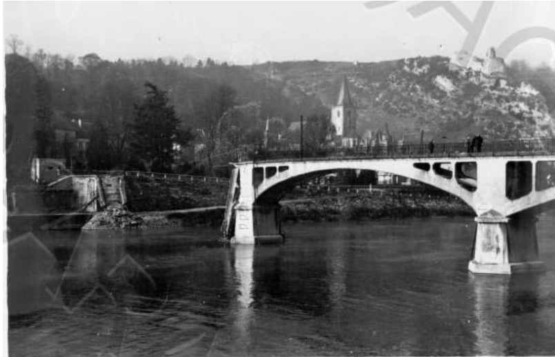
Figure 1: Passerelle de Bouvignes détruite (1940)
