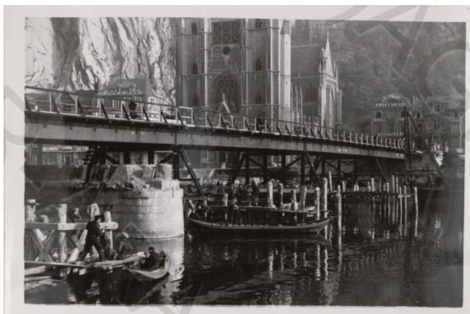
Figure 27 : Le pont de Dinant reconstruit en 1940
