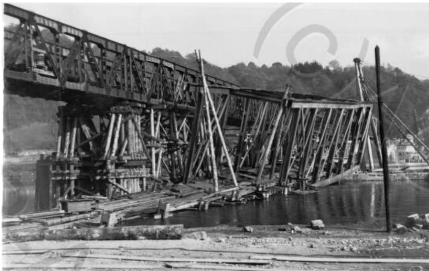
Figure 2: Le pont-rail d'Anseremme après son dynamitage (1940)
