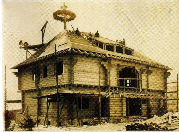
Fig. 5. Auteur inconnu, Maison Sommerfeld en construction , décembre 1920. Photographie argentique sur gélatine, 124 x 167 mm. Berlin, Bauhaus-Archiv.
