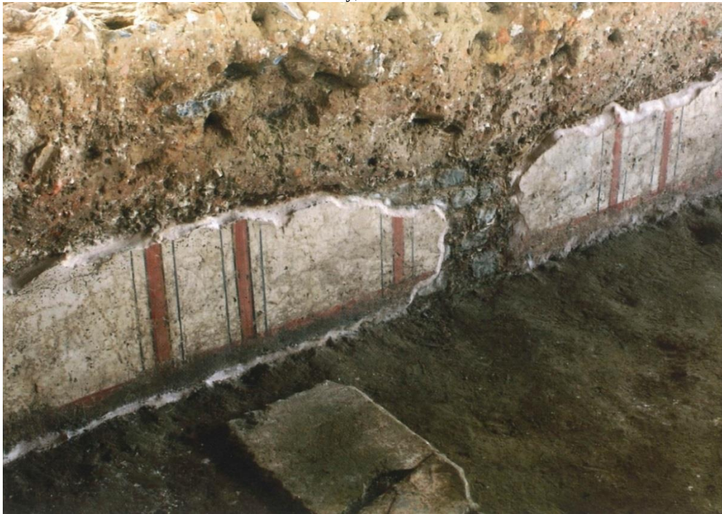
Fig. 92. Photographie de l'enduit peint conservé sur la partie basse du mur sud de la cave de l'aile sud du corps de logis de la villa du Champ de Saint-Éloi , Merbes-le-Château, Belgique. (Photographie : G. Focant, SPW/DGO4)
