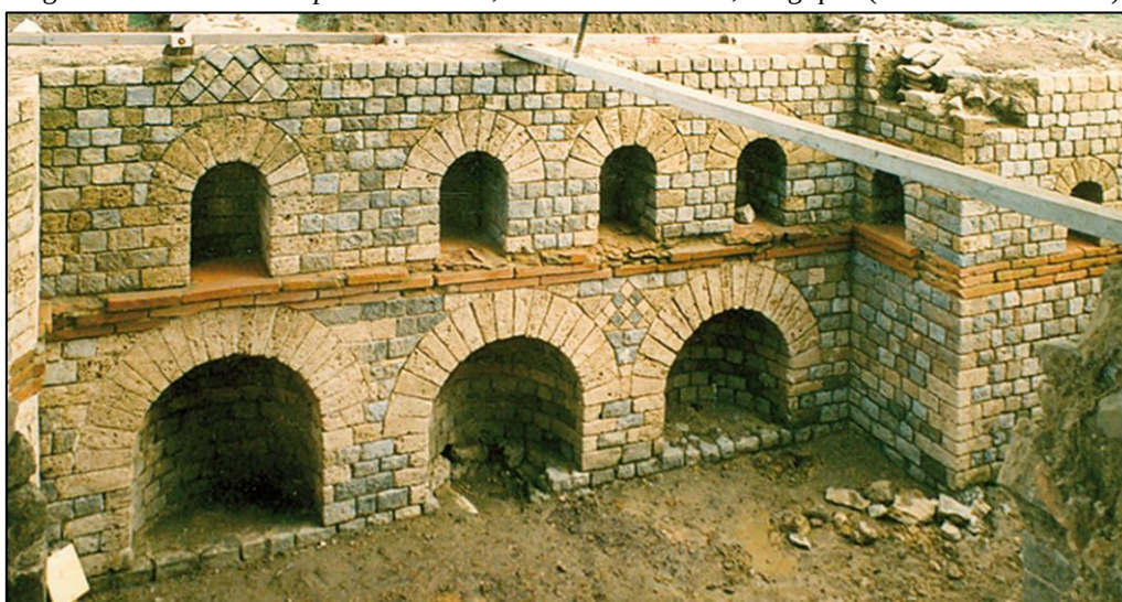
Fig. 71. Photographie du mur est de la cave de la villa des Machenées , Neuville, Belgique. (Photographie : Archéophil, Fonds Cedarc/Musée du Malgré-Tout, Treignes)
