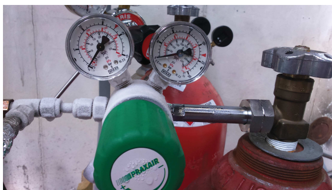
FIGURE 2.7 – Conduite en sortie de bonbonne givrée suite à des essais sur le banc
