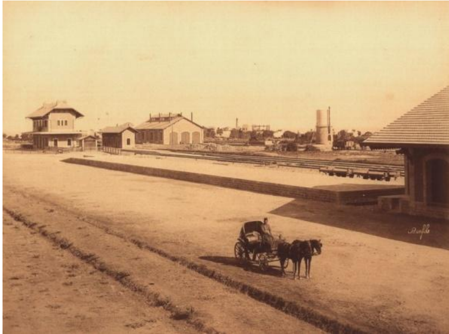
(Fig. 13 : La station de trains de Mar Mikhael, 1895 (source : wikipedia.com, consulté le 10 décembre 2021)
