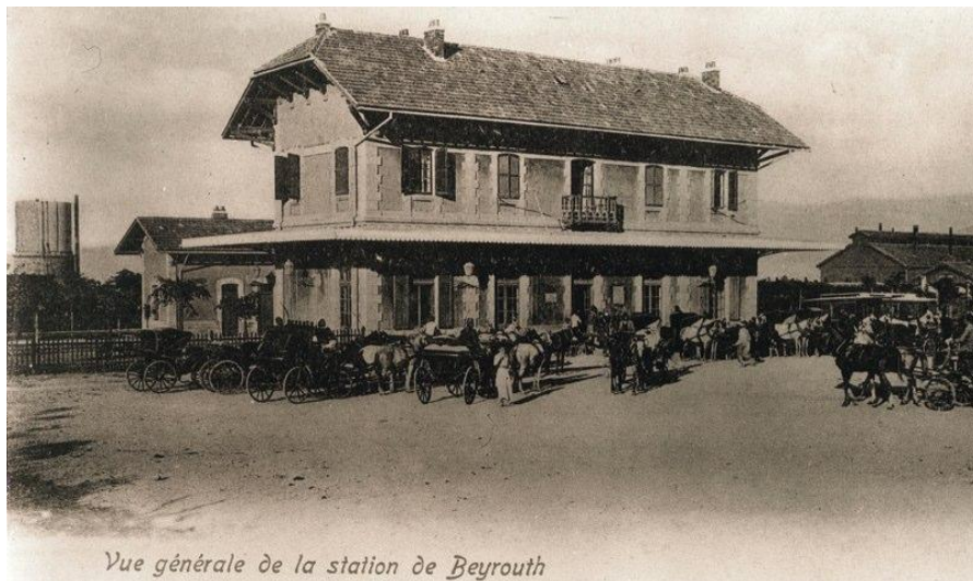
Fig. 14 : Le Bâtiment des Voyageurs, 1900 (source : wearelebanon)
