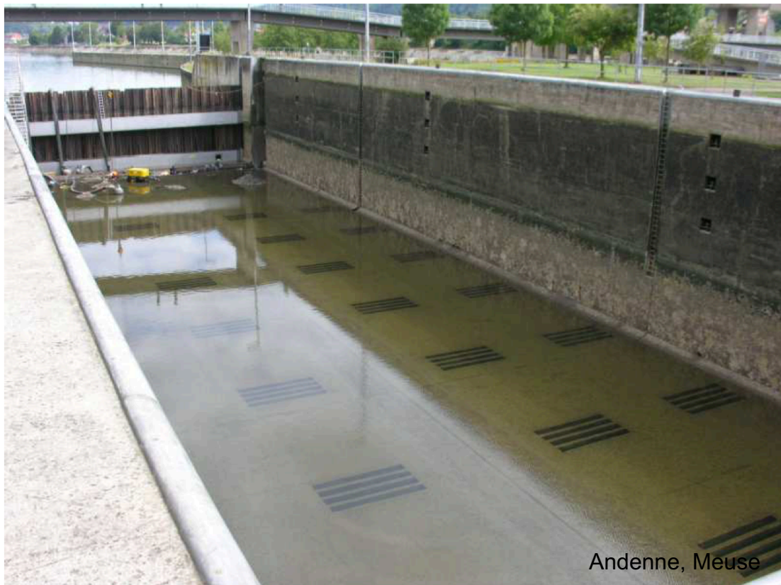
Figure 2-18 : Image écluse - Alimentation par le radier (Bousmar, 2020)
