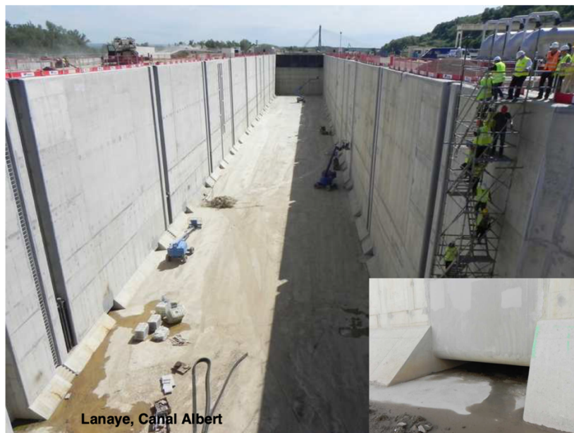
Figure 2-16 : Image écluse - Alimentation par aqueducs-larrons (Bousmar, 2020)
