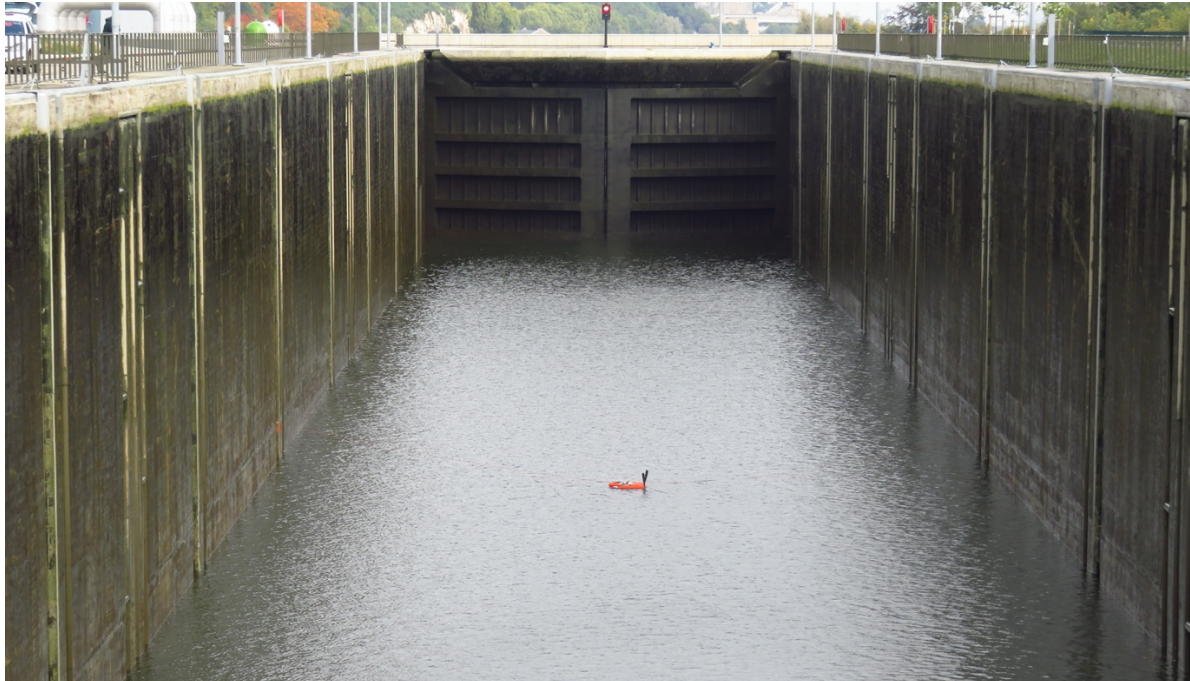
Figure 5-62 : Sonde ADCP dans le sas (Service Public de Wallonie, 2017)
