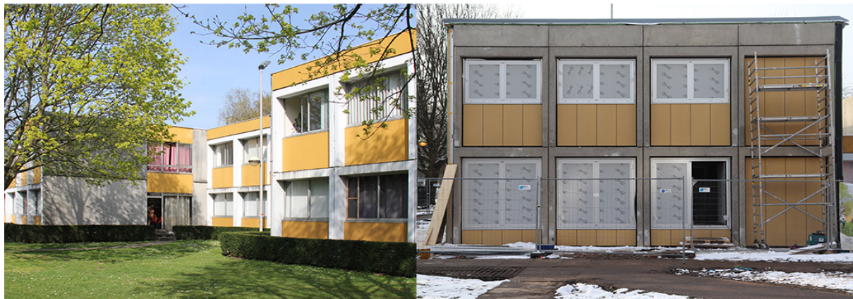
Fig. 32 : Façades du Circular Retrofit Lab Source : BAMB, VUB, Kaderstudio, 2019
