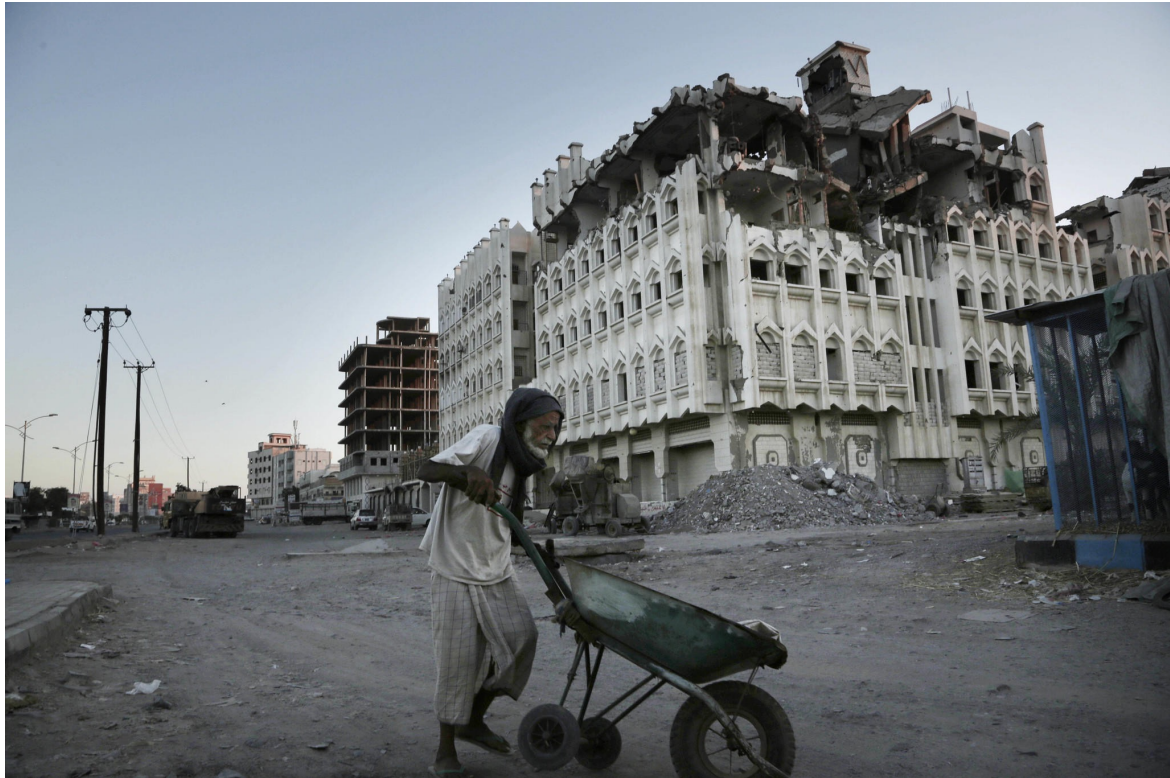
Un homme marche à côté d'un bâtiment endommagé par les conflits de 2015 à Aden, dans le Sud du Yémen. « Civil war leaves Yemen's port city of Aden a bombed-out husk », Los Angeles Times , 20 juin 2018, consulté en ligne le 20 mai 2019, https://www.latimes.com/world/middleeast/la-fg-yemen-civil-war-unfurled-2018-htmlstory.html .
