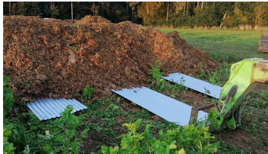
Figure 13 : Positionnement des tôles de récupération par enfouissement à l'aide du chargeur du Merlot
