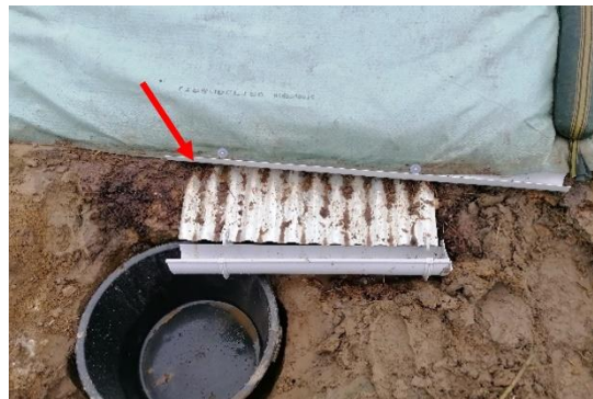
Figure 16 : Court-circuitage du ruissellement provenant du géotextile à l'aide d'une gouttière en PVC fixée au géotextile
