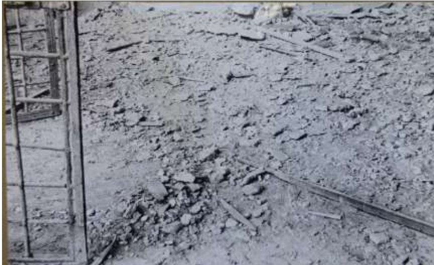
Fig.9. Chapelle Mazzatosta, Santa Maria della Verità, Viterbo. Vue des fragments d'enduits peints recouvrant le sol après les bombardements aériens, 1944.
