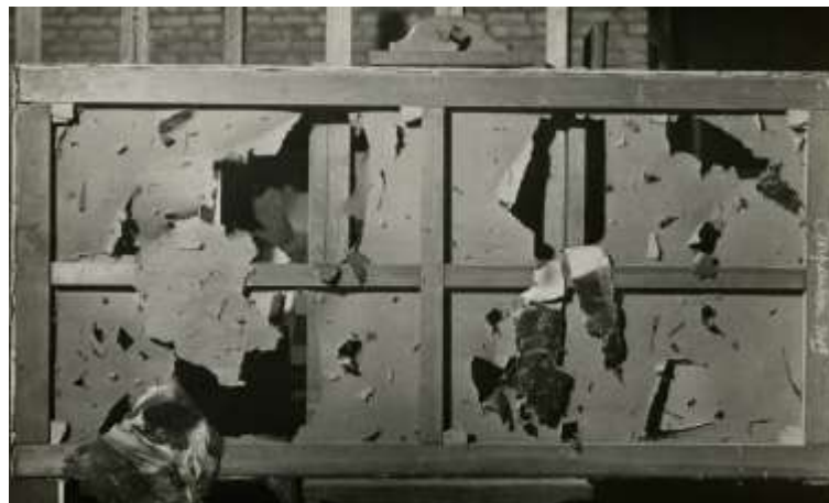
Fig.41. Evariste Carpentier, La révolte en Vendée , inv. 1009, Musée royal des Beaux-Arts d'Anvers, 1944. Image totale des dégâts causés sur le revers par la bombe-V le 13 octobre 1944.
