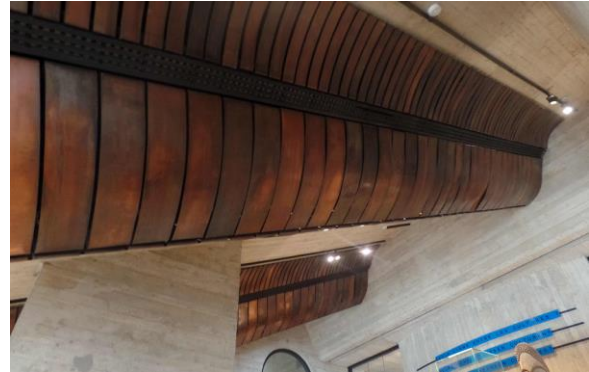
Fig.5. Louvain-la-Neuve, Musée L, gaines de chauffage en cuivre de J. Wabbes, cliché de M. Dewandre, mai 2019.
