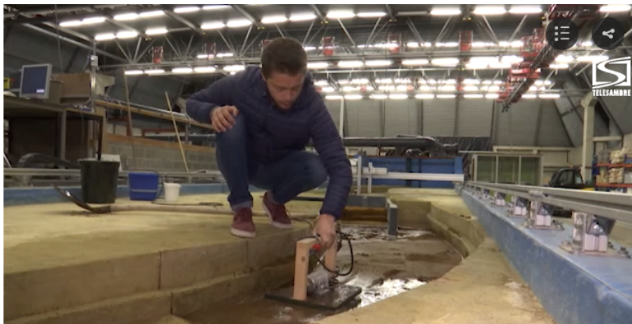
FIGURE 2.26 – Mise en place des coquilles de noix
