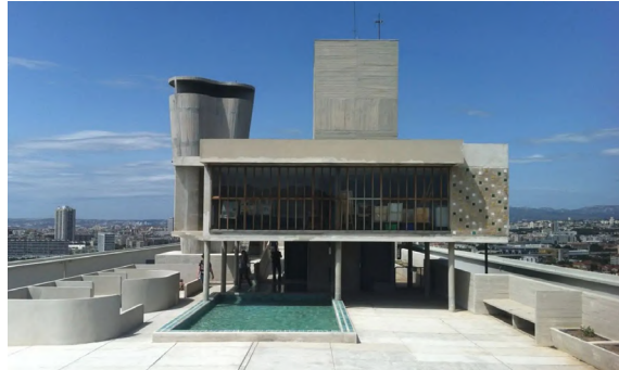
Fig. 56 Toit-terrasse de la Cité Radieuse, Le Corbusier, Marseille (1952)
