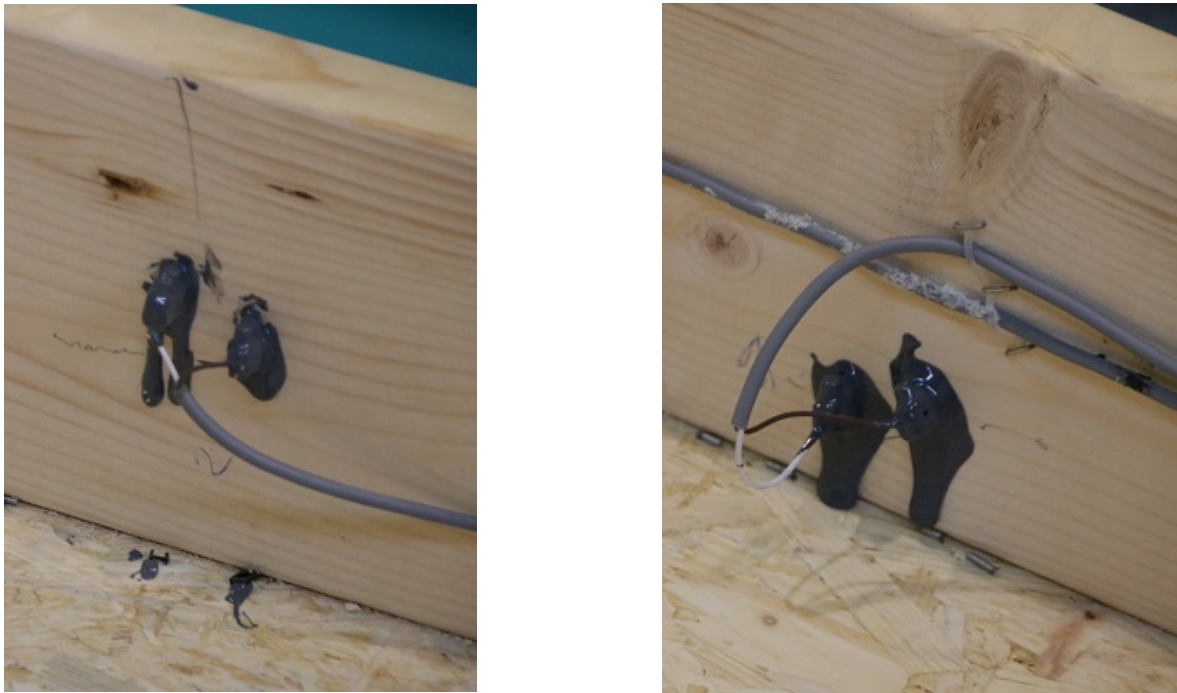
FIGURE 7.3 – Ensemble pointe-connecteur-câble à une distance de 0,5 fois (à gauche) et 0,3 fois (à droite) la largeur de la pièce à partir de l'une des rives
