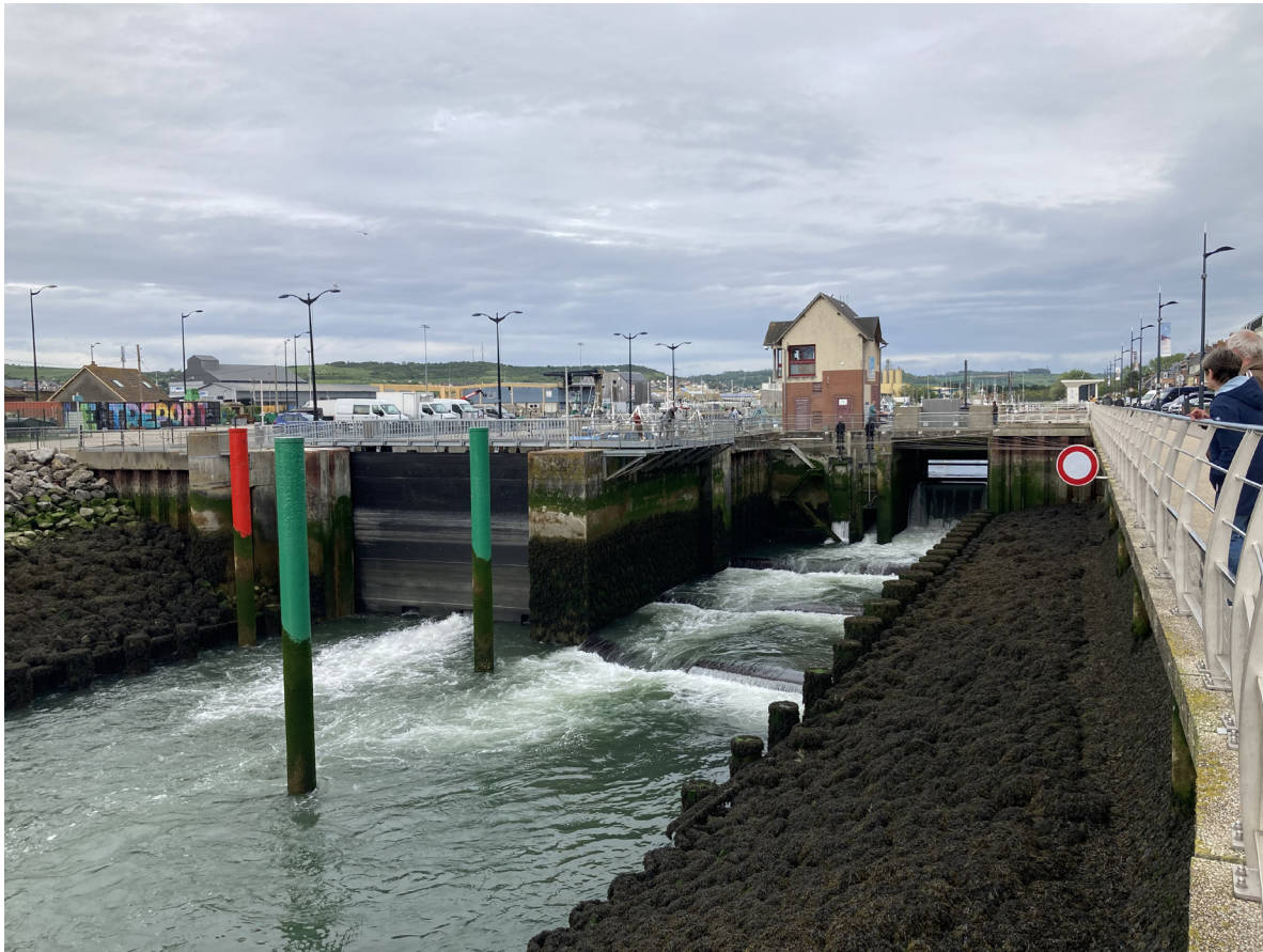
75 : Ecluse entre l'avant port et le port de pêche/plaisance et passe à poisson
