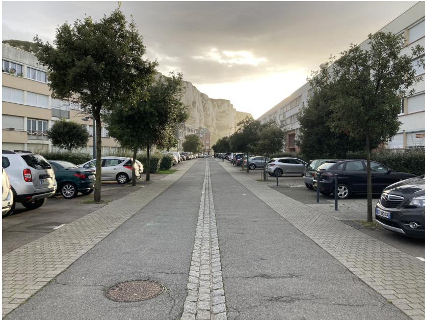
84 : La façade arrière de la barre de logement du front de mer
