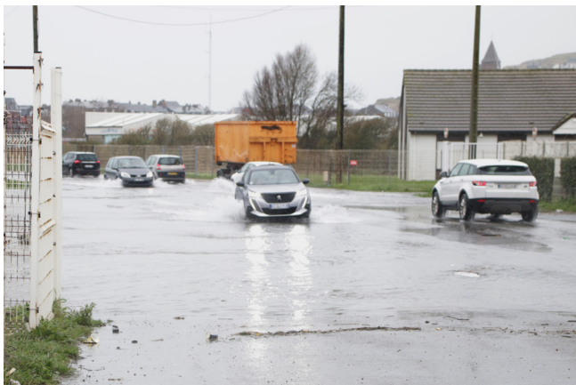
49 : Débordement d'eau passant sur la D1015
