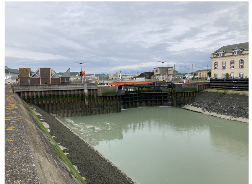
77 : Ecluse entre le port de commerce et l'avant port
