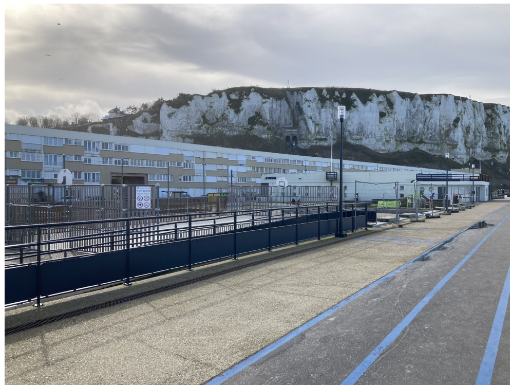
69 : La nouvelle barre de logements
