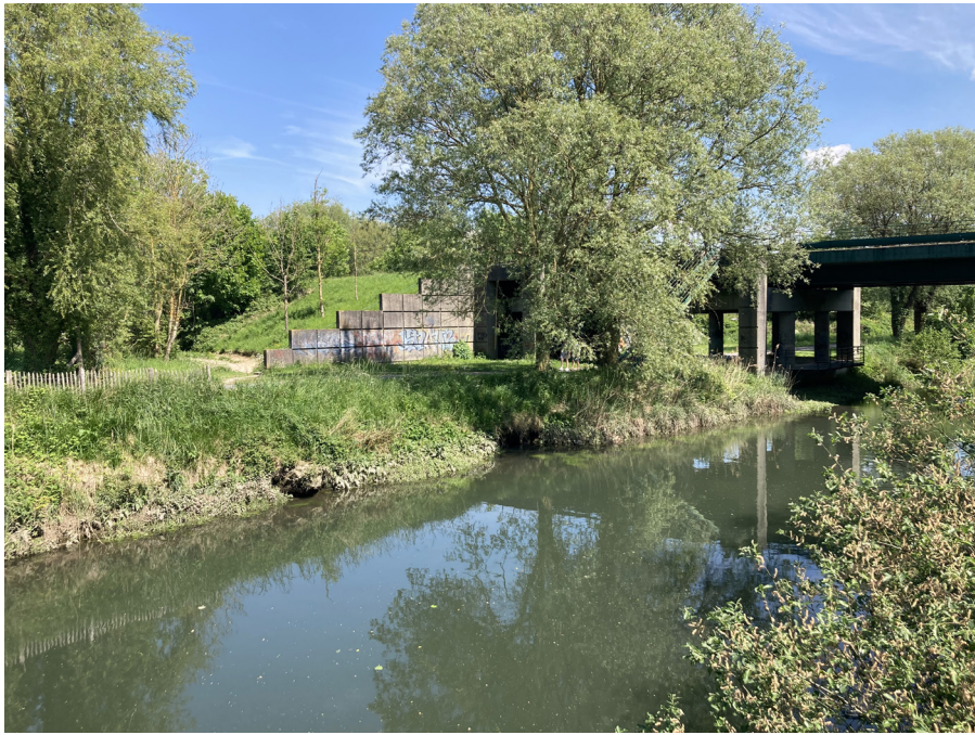
19 : Pont de la D 925 au dessus de la Bresle
