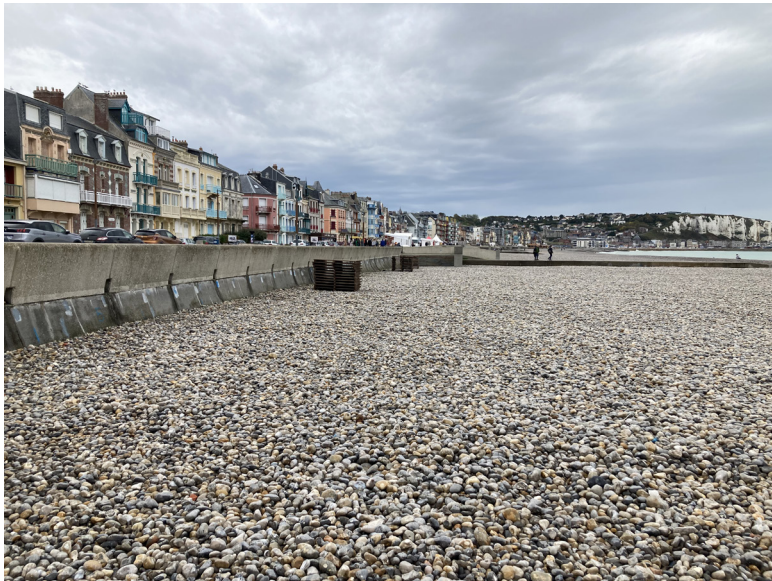
Le parapet de la digue
