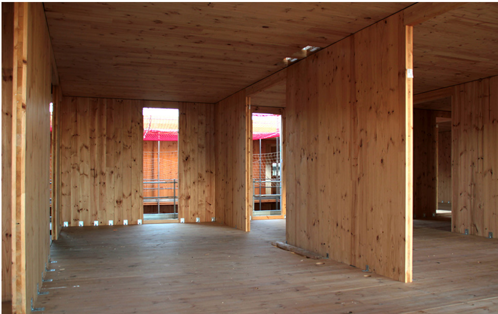
Photo de chantier de La Borda
