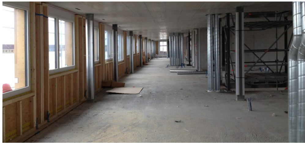
Photo de chantier de Kalkbreite
