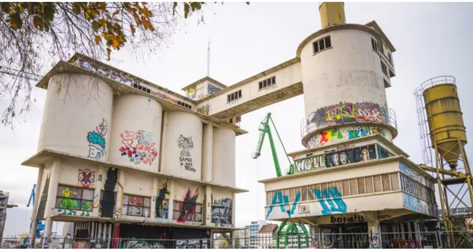
Inter Béton, ancienne centrale à béton, appropriée par les graffeurs
