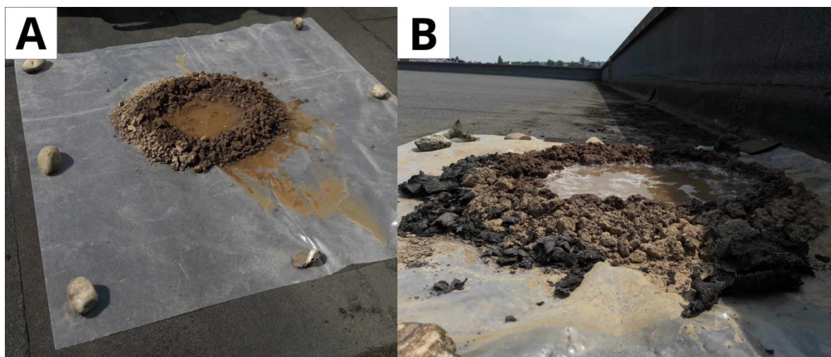
Figure 16 : Test de la bâche - A. Bâche sur le toit de l'Aula Magna - B. Bâche sur le toit du Cinéscope.
