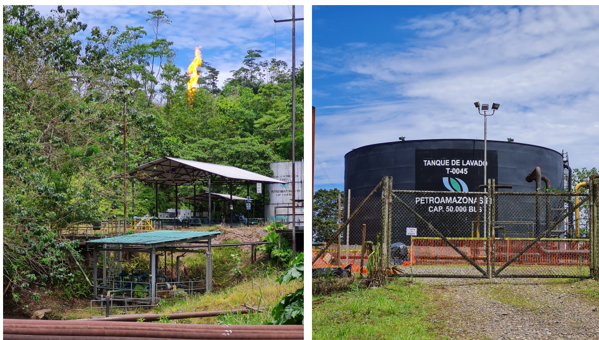
Figure 16. Entreprise d'exploitation de pétrole à la lisière du
