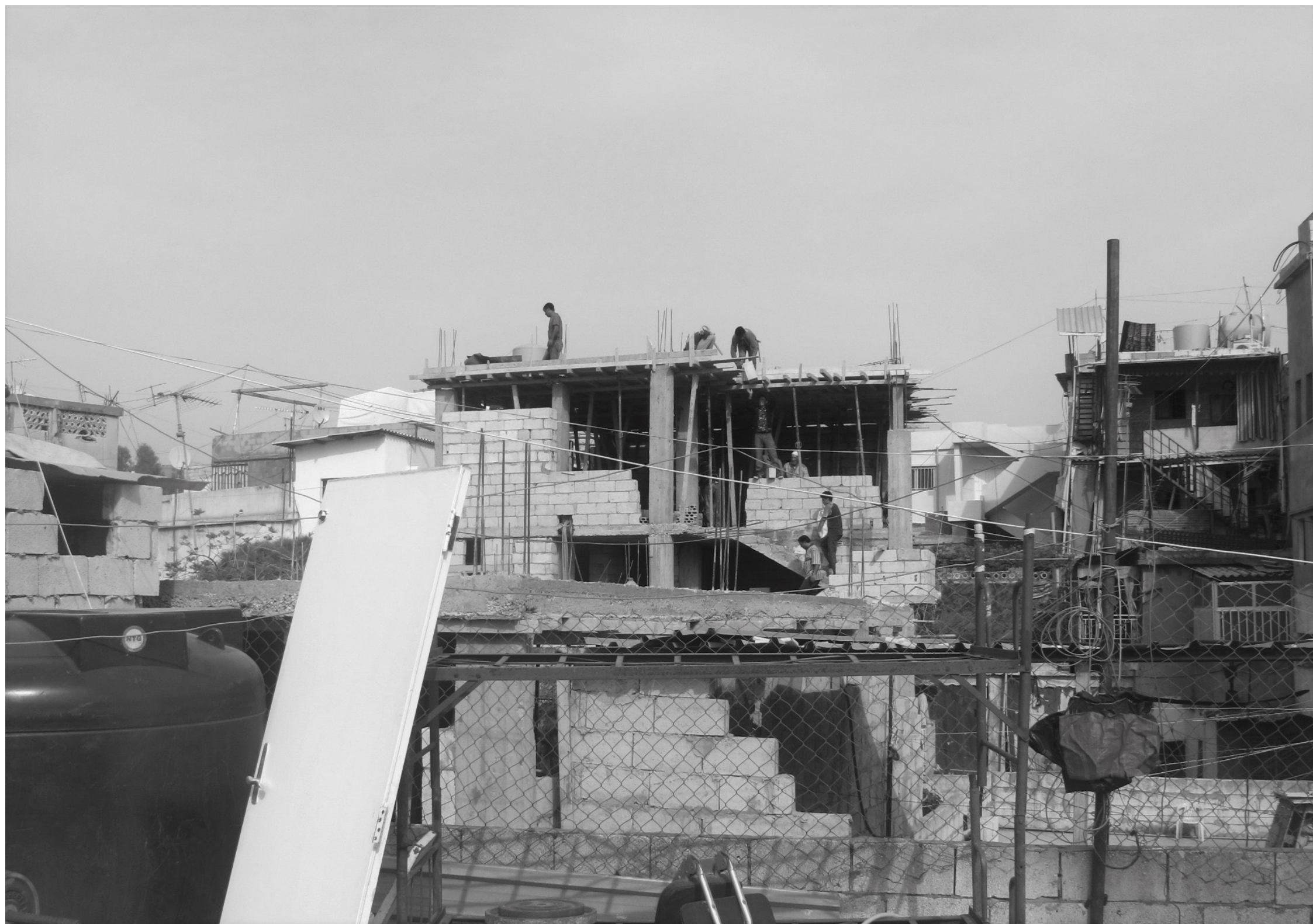
Fig.56: Photo d'un chantier à Sabra , réalisé par Antoun Rizk
