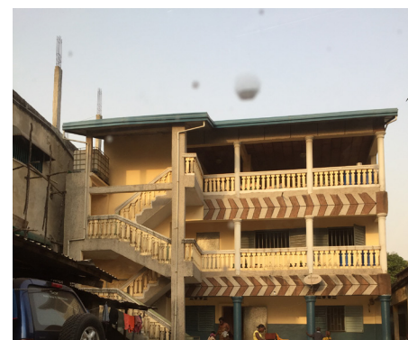
Image 75 : Construction moderne à Conakry. Agathe Studer, 2022
