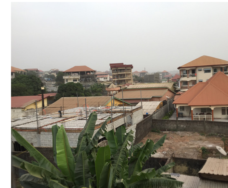
Image 76 : Construction moderne à Conakry. Agathe Studer, 2022
