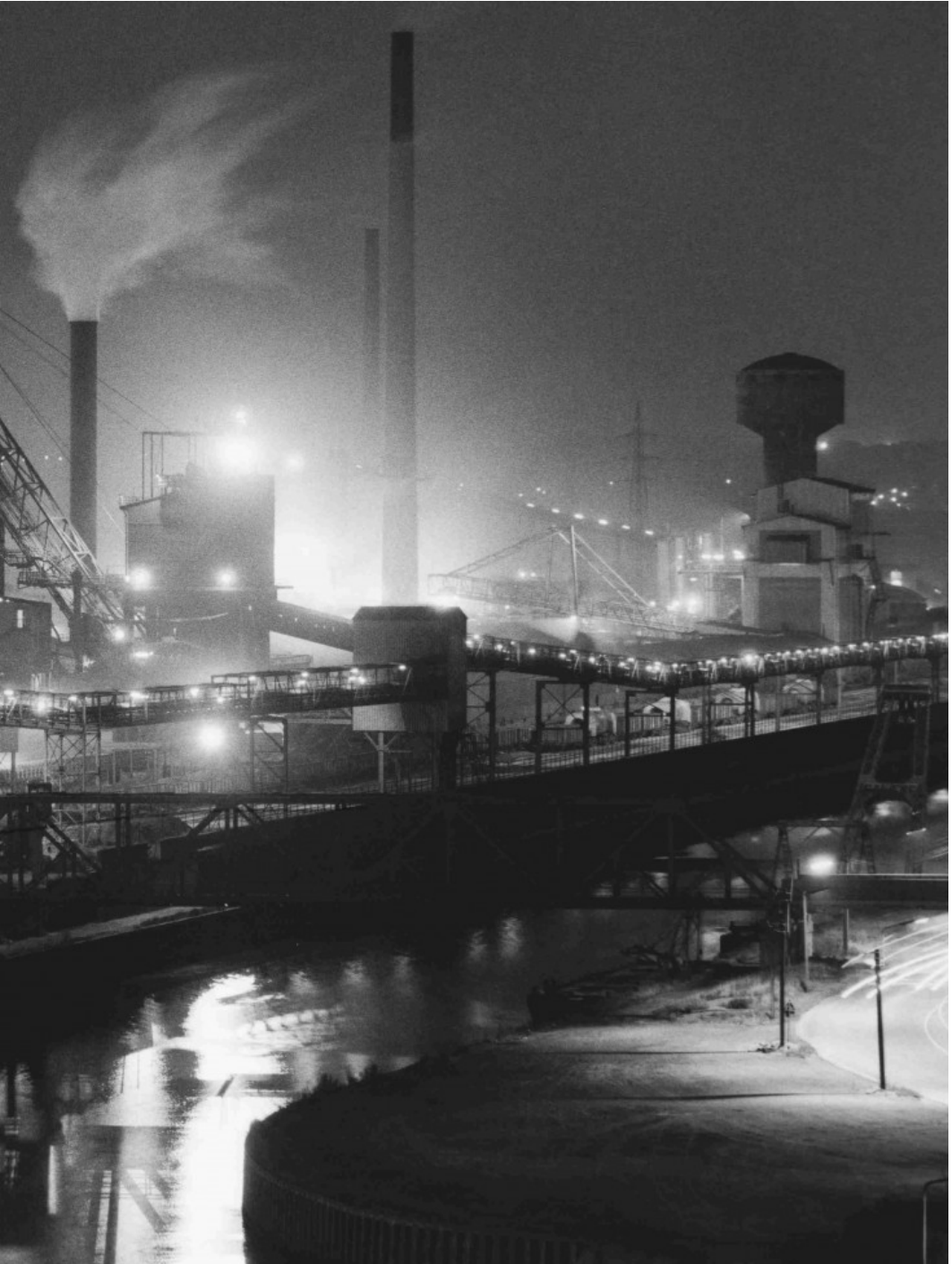
Photo 10 Les usines de Charleroi (1990)
