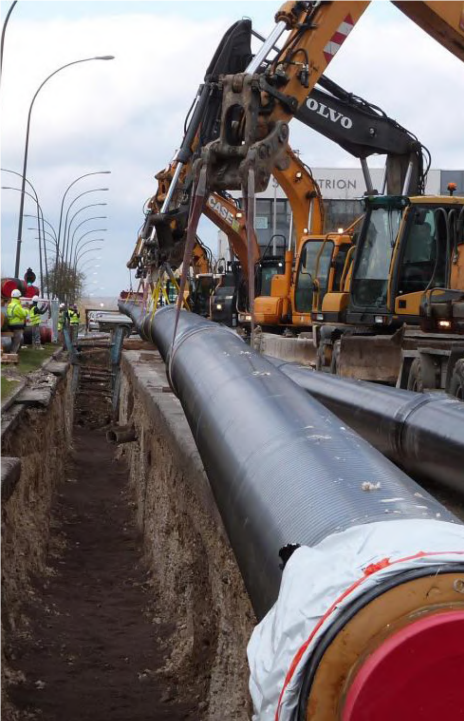
Photo 25 Construction d'un réseau de chaleur à Amiens (France)
