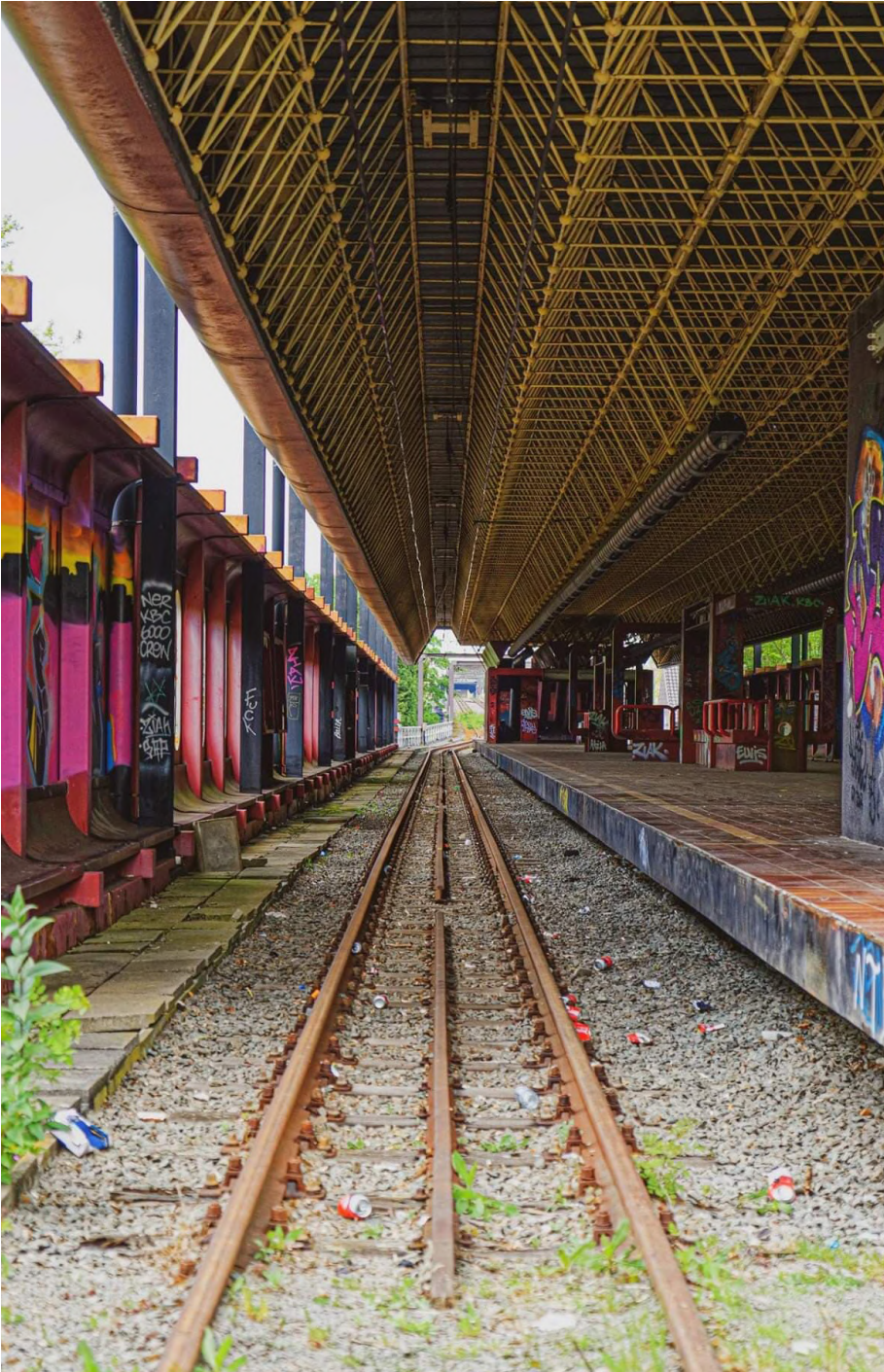
Photo 44 Infrastructures déchets La station « Chet » du métro abandonné
