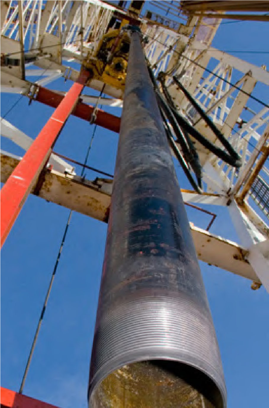
Photo 29 Tube de coulage utilisé pour le gainage d'un puits de forage géothermique Munich (puits de +/- 3000 mètres)
