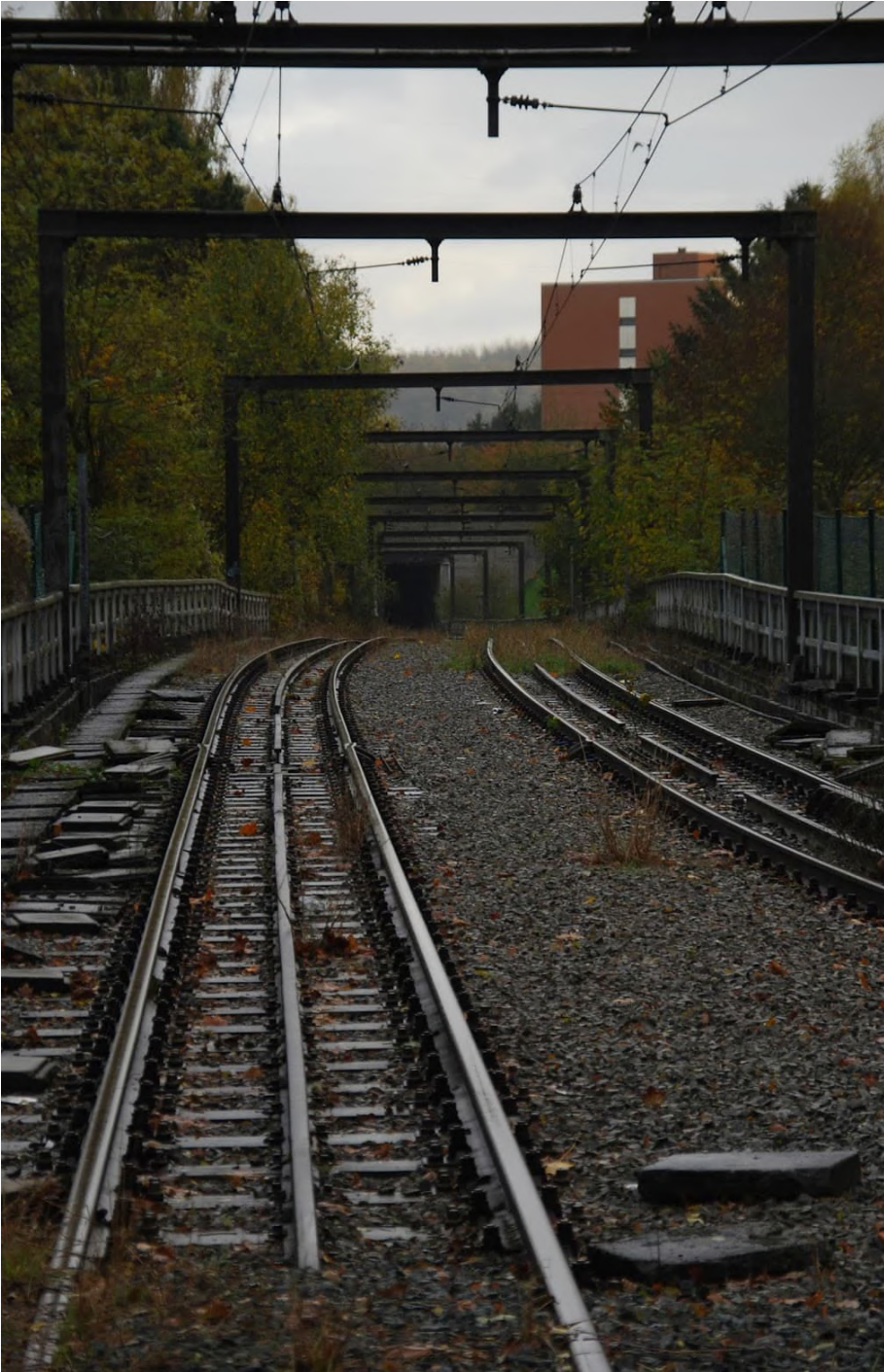
Photo 46 Infrastructures déchets La « ligne fantôme » du métro abandonné
