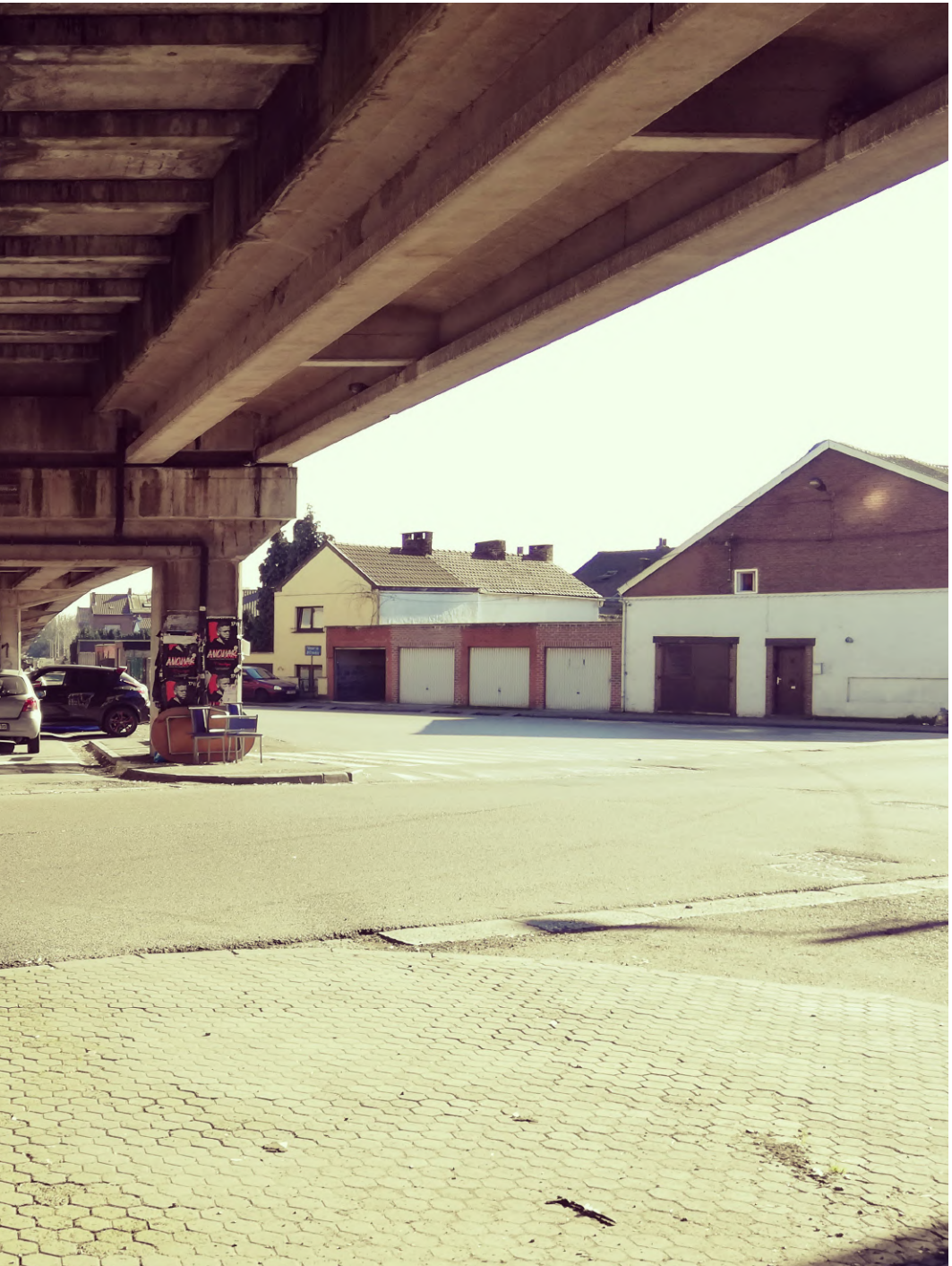
Photo 47 Infrastructures déchets Les sous-infrastructures du métro abandonné
