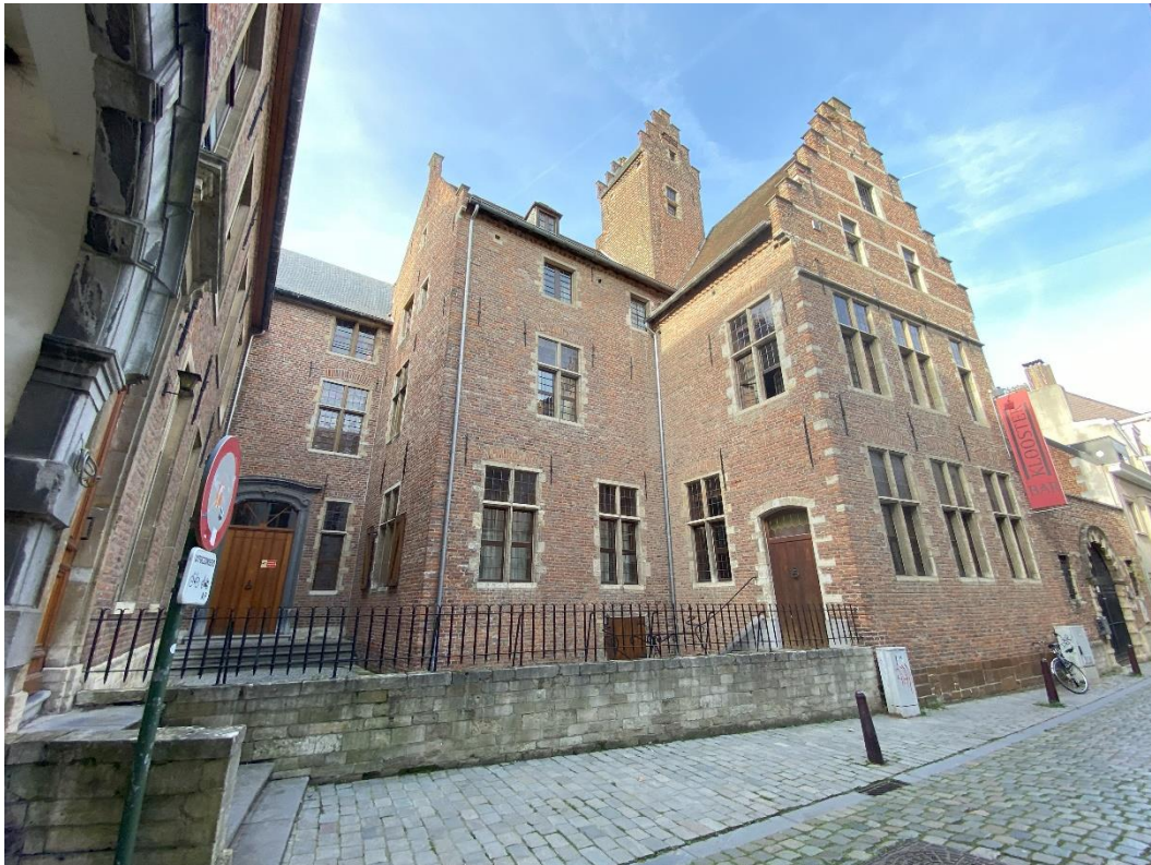
Figure 111 : © PALAGI E., Vue depuis la rue Predikherenstraat, Klooster, Louvain, avril 2024, [Photographie]
