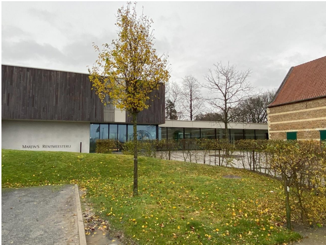
Figure 90 : © PALAGI E., Entrée principale, Rentmeesterij, Bilzen, décembre 2023, [Photographie]
