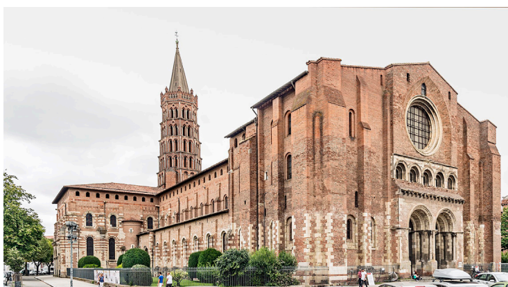
Fig. 25 Photographie de la composition d'ensemble de la basilique. Source : Didier Descouens © CC BY-SA 4.0
