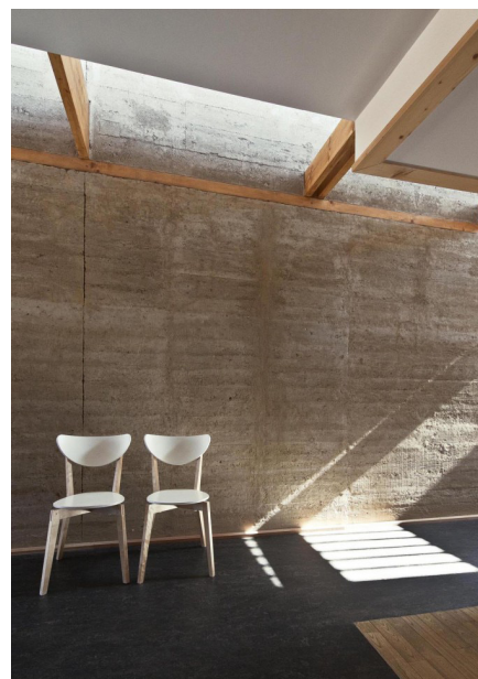
Figure 52 : Mur trombe du projet de l'espace rural de proximité à Marsac-en-Livradois
