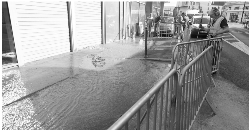
Rue du Maréchal Foch. Roubaix. Le 18 septembre 2019 300 logements privés d'eau après une rupture des canalisations
