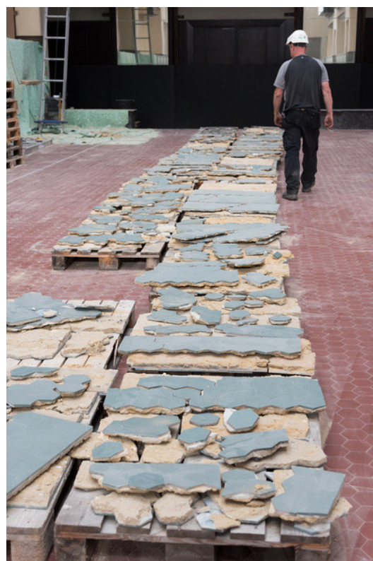
Figure 34 - Origin : Dépose des revêtements de sols carrelés
