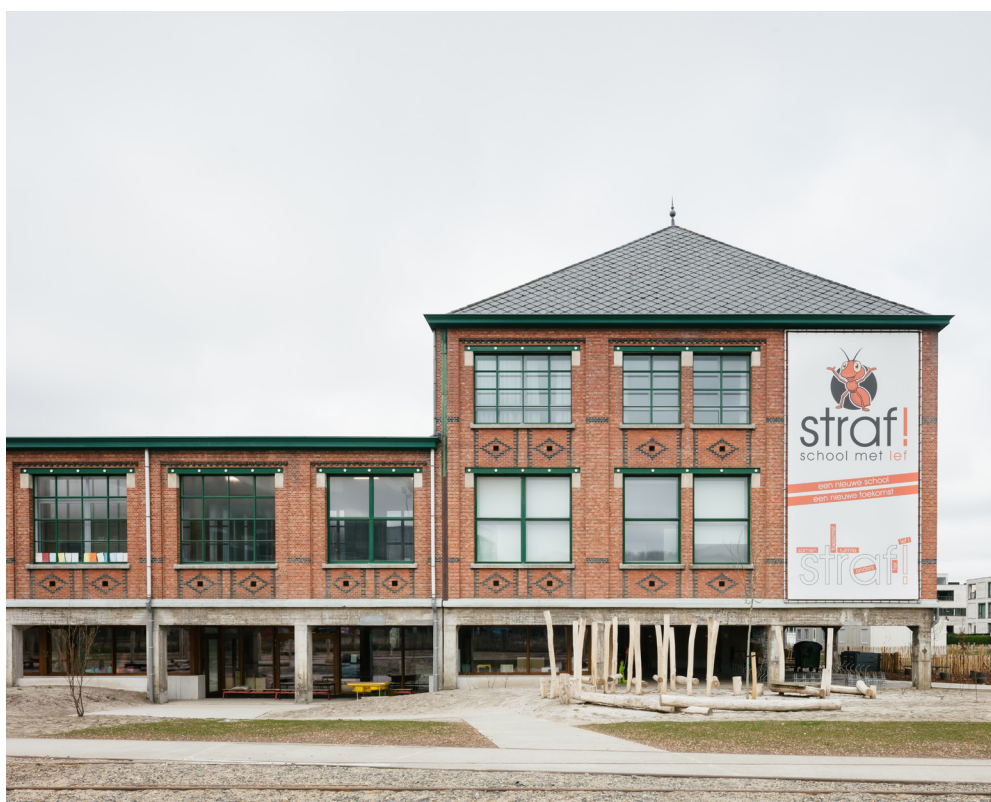
Figure 19 - a2o : façade d'entrée de l'école
