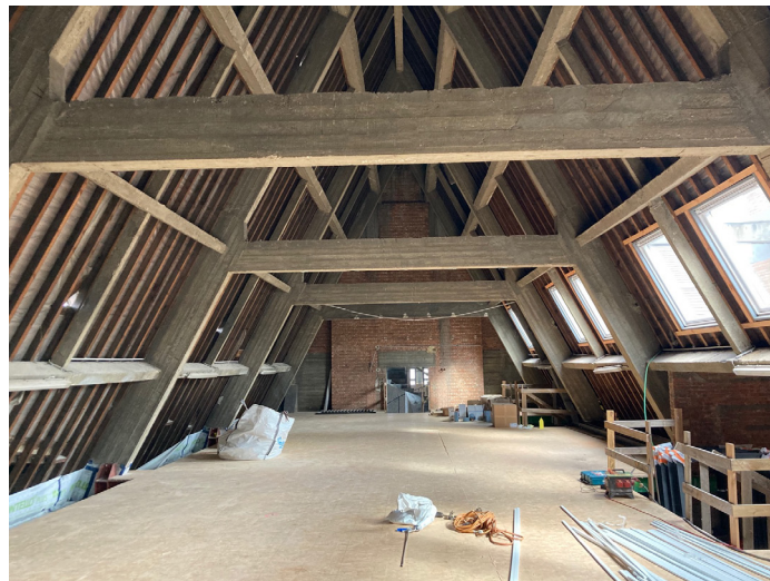
Figure 35 - Origin : photo des combles avant les travaux
