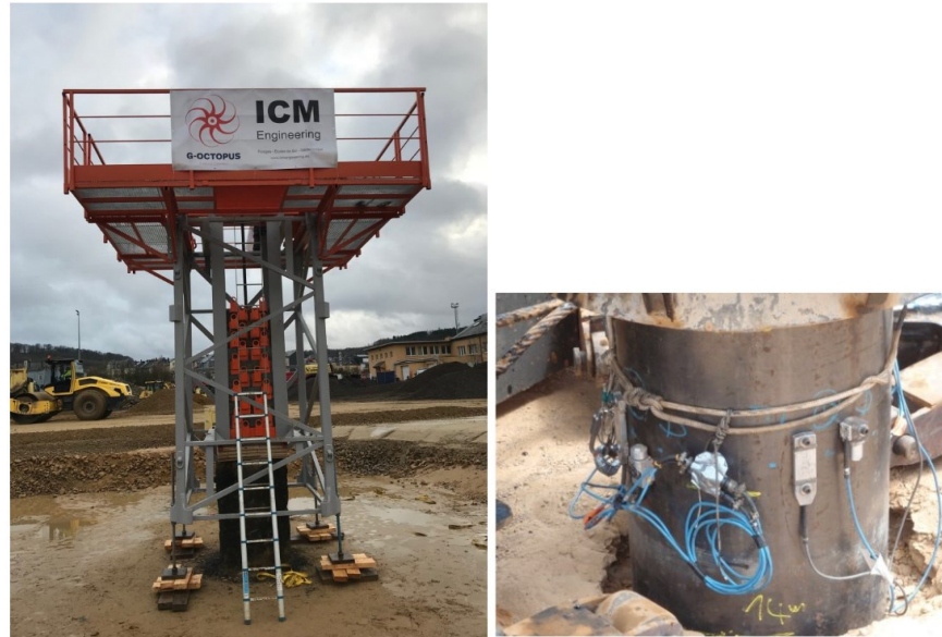
Figure 12 : Essai de chargement dynamique (3)
