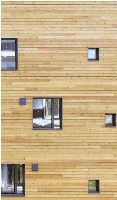
■ Fig.62 : Façade exclusivement en bois
