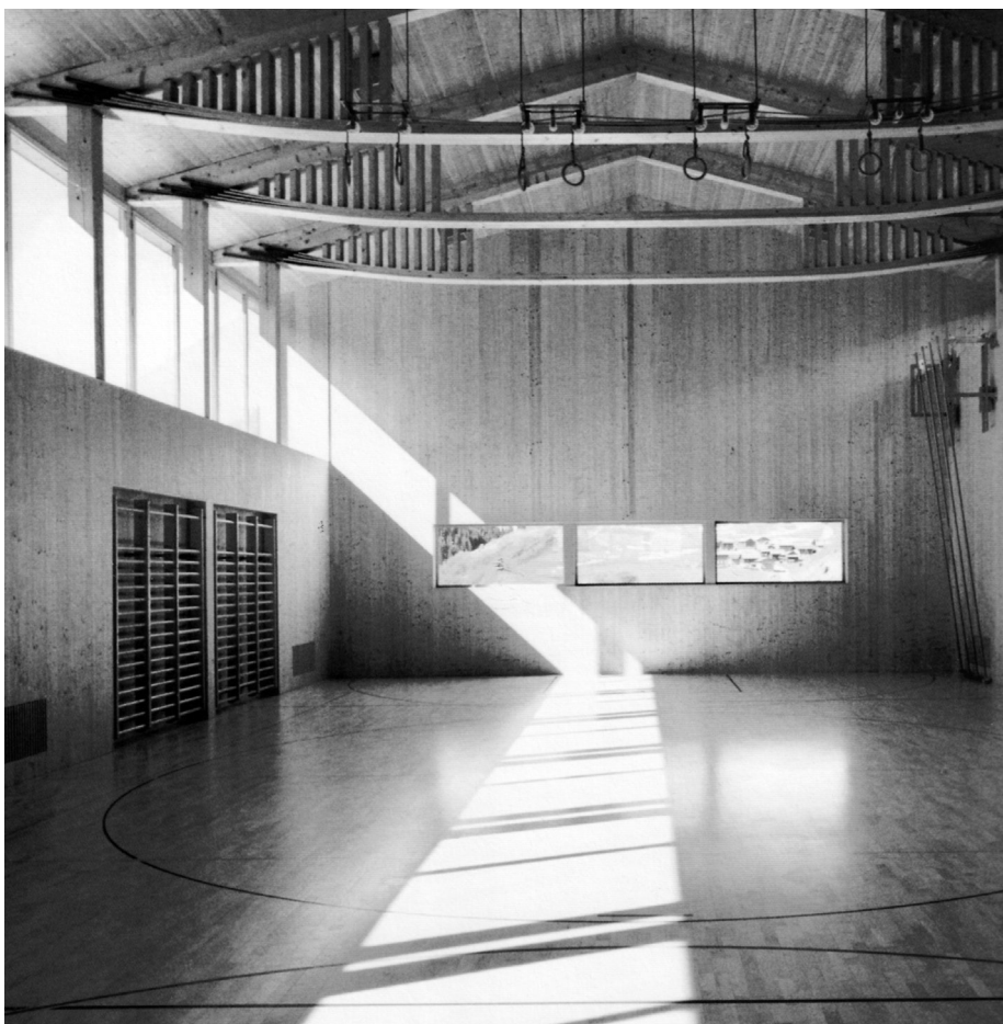
■ Fig.12 : Une charpente utilisant le bois en traction. Le dessin final de la charpente comporte cinq lattes en bois lamellé de 24 mm d'épaisseur servant de tirants. Aux appuis, les planches stratifiées sont maintenues par des lamelles métalliques individuelles, rendant la construction cohérente.
