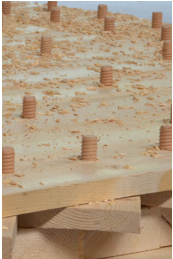
■ Fig.63 : Stratification des couches en bois
