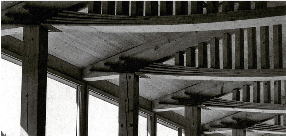
■ Fig.55 : Pincement des planches de part et d'autre pour franchir les 6m de portée
