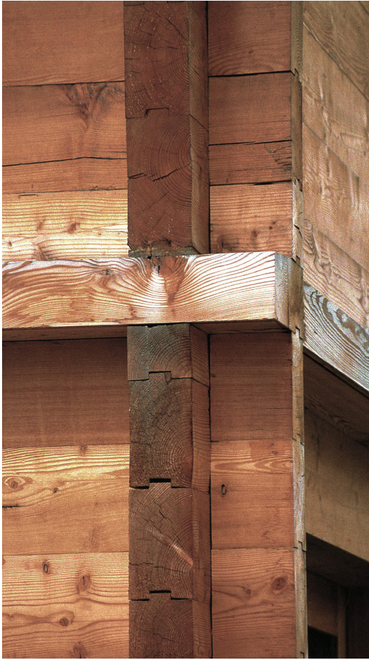
■ Fig.18/19 : Détails constructifs en bois (à gauche) d'un chalet récent de Vrin, (à droite) d'un ancien chalet (à droite)
