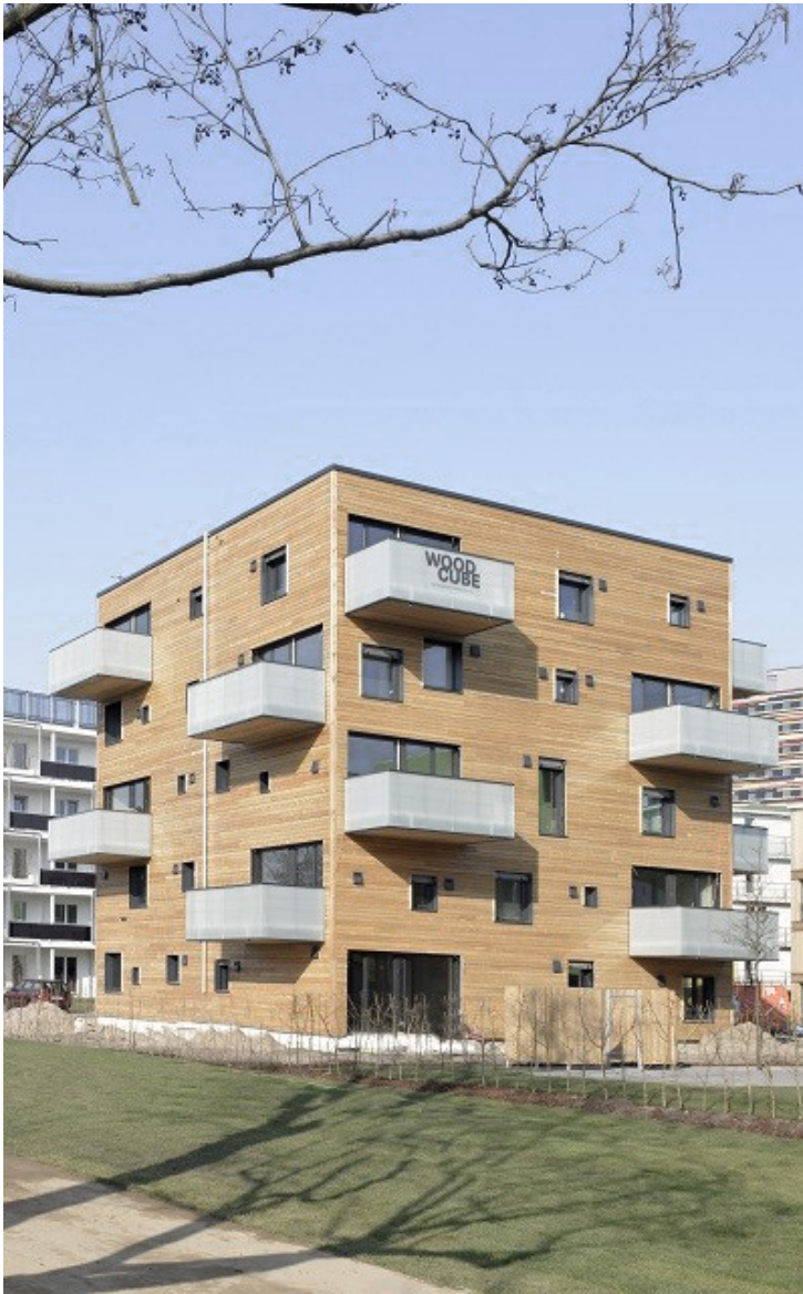
■ Fig.58 : Le bois comme ossature et finitions internes et externes
