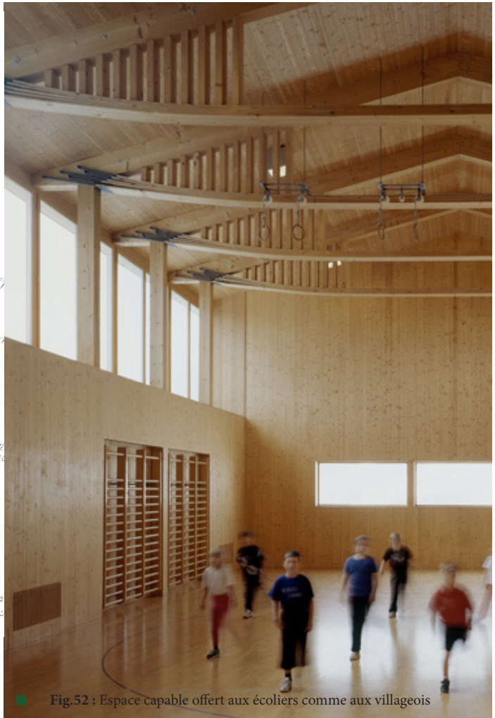
■ Fig.51 : Charpente en bois travaillant en traction
