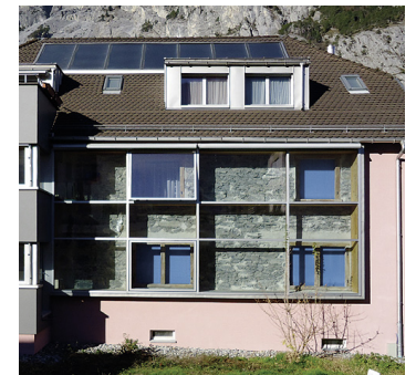
III.38 Application du mur capteur-trombe
